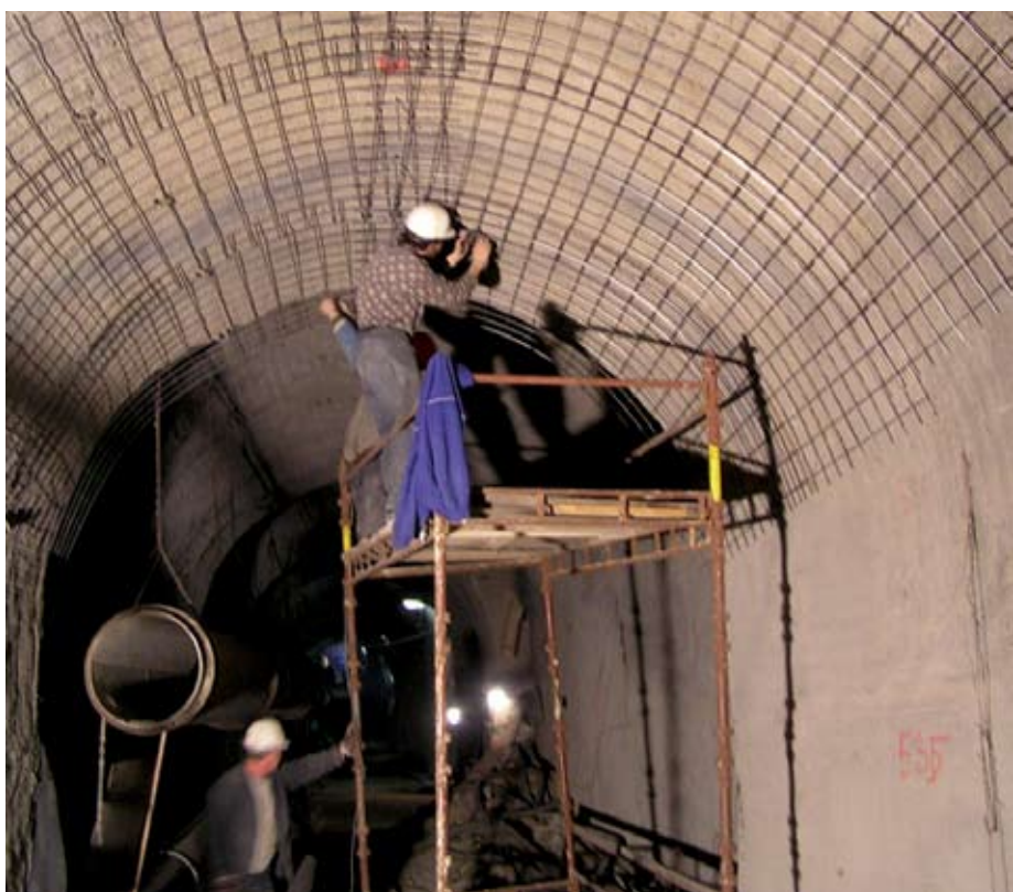
Kolektor Centrum I. A, Vodičkova ulice, Praha
