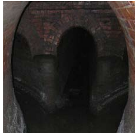
Sanace kanalizace v ulici Křížkova, Praha
