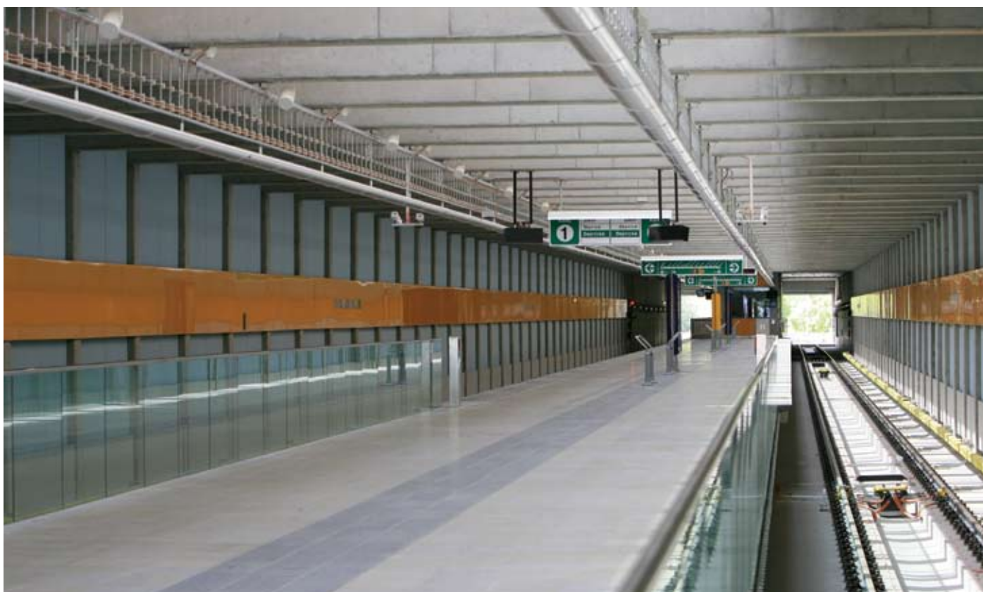
Stanice metra Depo Hostivař, Praha
