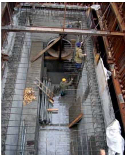
Stavba MÚK Malovanka, Strahovský tunel Praha
