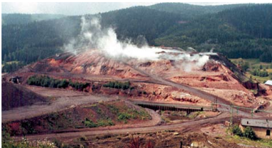
Sanace hořícího odvalu bývalého Dolu Kateřina v Radvanicích o objemu 2,3 mil m 3 hmoty v roce 2005
