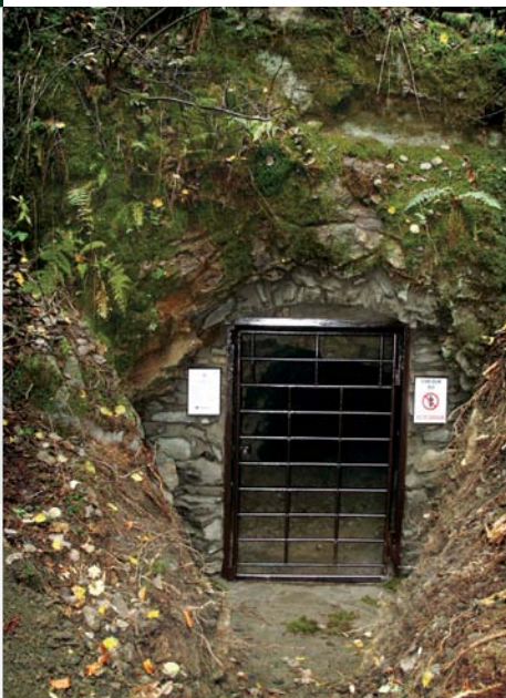
ŠTOLA BŘIDLIČNÁ PO ZAJIŠTĚNÍ
