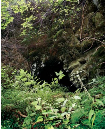
ŠTOLA BŘIDLIČNÁ PŘED ZAJIŠTĚNÍM
