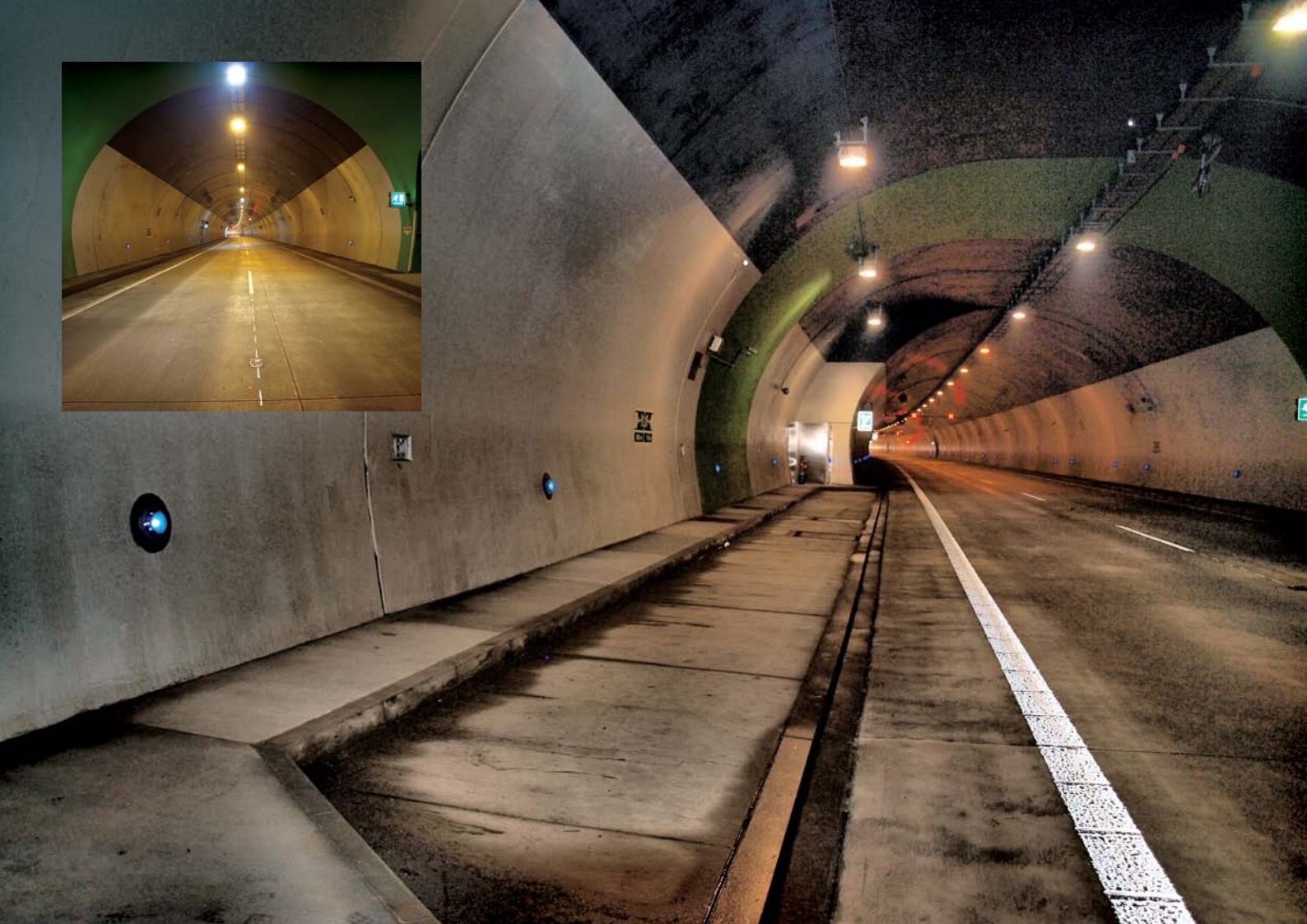
MONITOROVANÉ PODZEMNÍ DÍLO KLIMKOVICKÝ TUNEL
