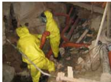
Pokládka splaškové kanalizace
