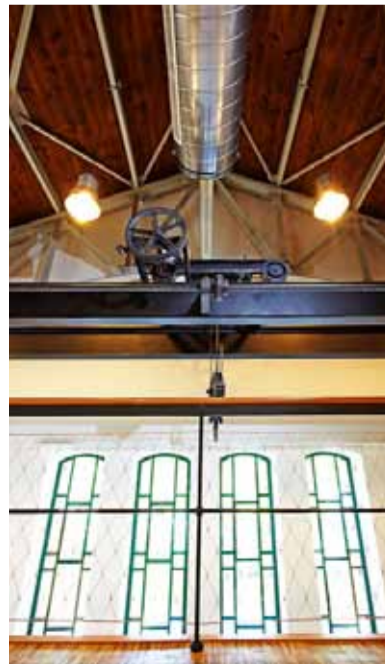
Po odborné demontáži a restaurování byla opětovně použita historická jeřábová dráha s kočkou.
