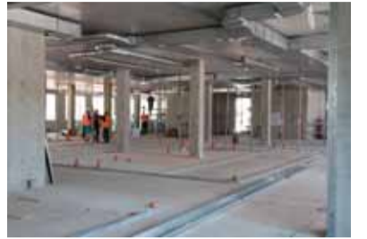
Vnitřní prostory jsou děleny sádkartonovými příčkami v kombinaci s hliníkovými portály
