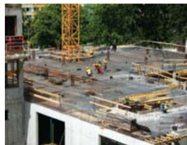
Stavba vodojemu Nebovidy o objemu komor 2500 a 1600 m 3
