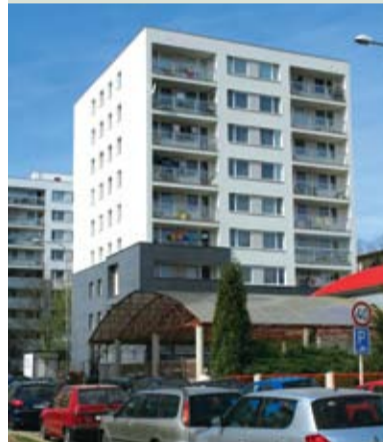
Rekonstrukce domu v ul. Habrové, Praha
