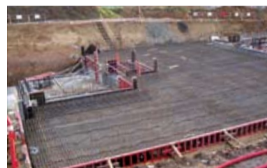
Stavba vodojemu Nebovidy o objemu komor 2500 a 1600 m 3
